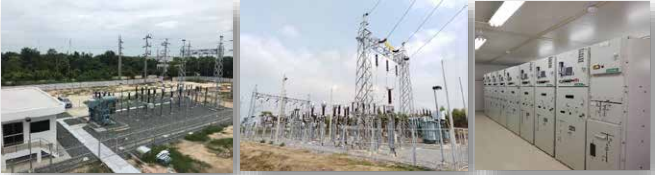
โครงการก่อสร้างสถานีไฟฟ้าแรงสูง
