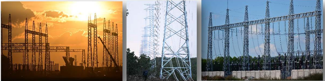
โครงการก่อสร้างสายส่งไฟฟ้าแรงสูง
