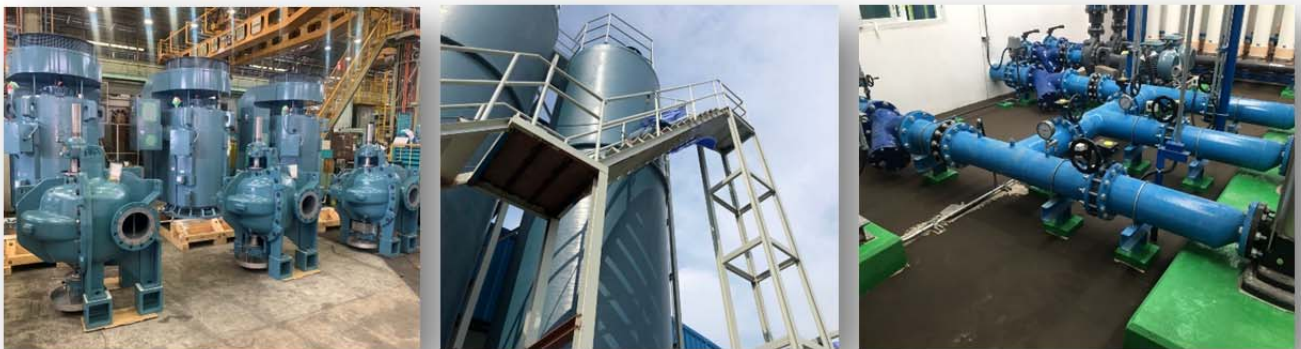
โครงการก่อสร้างโรงผลิตและจำหน่ายน้ำแบบครบวงจร
