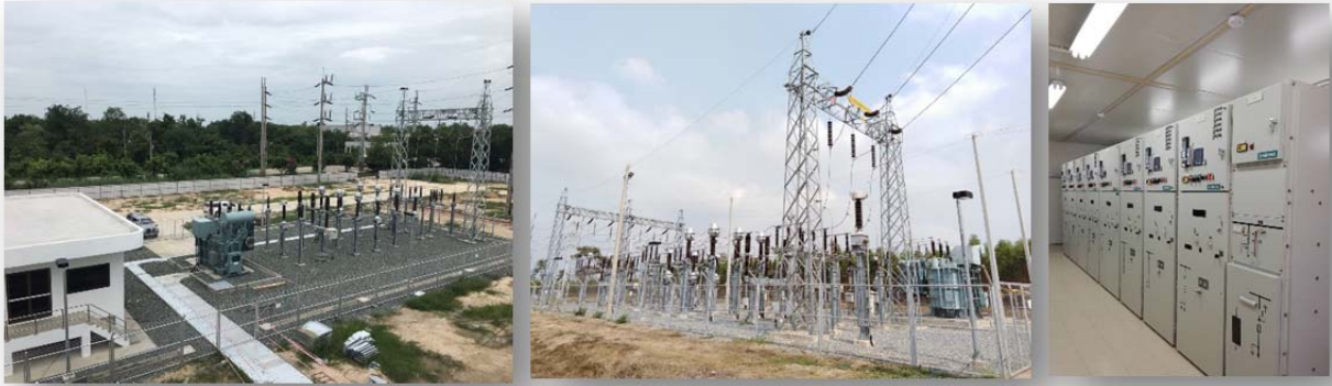
โครงการก่อสร้างสถานีไฟฟ้าแรงสูง
