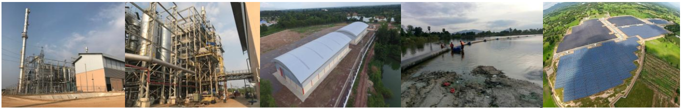
โครงการก่อสร้างโรงไฟฟ้าเชื้อเพลิงขยะอุตสาหกรรม
